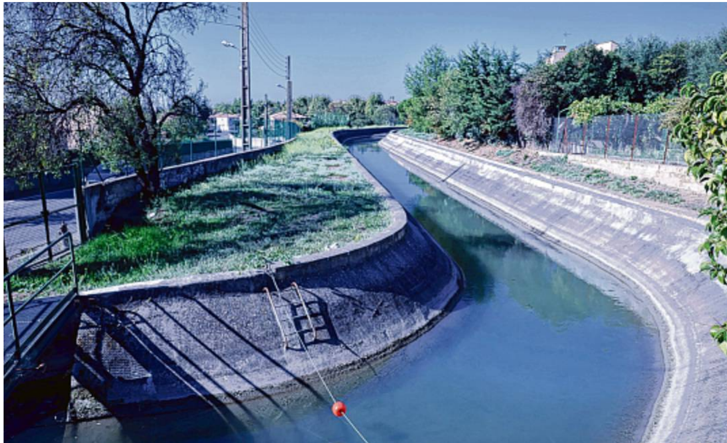
Comme ici à l'avenue d'Albret dans le 13 e arrondissement, de nombreuses parcelles jouxtant le canal vont être frappées d'interdictions de construire. /PHOTO VALÉRIE VREL
